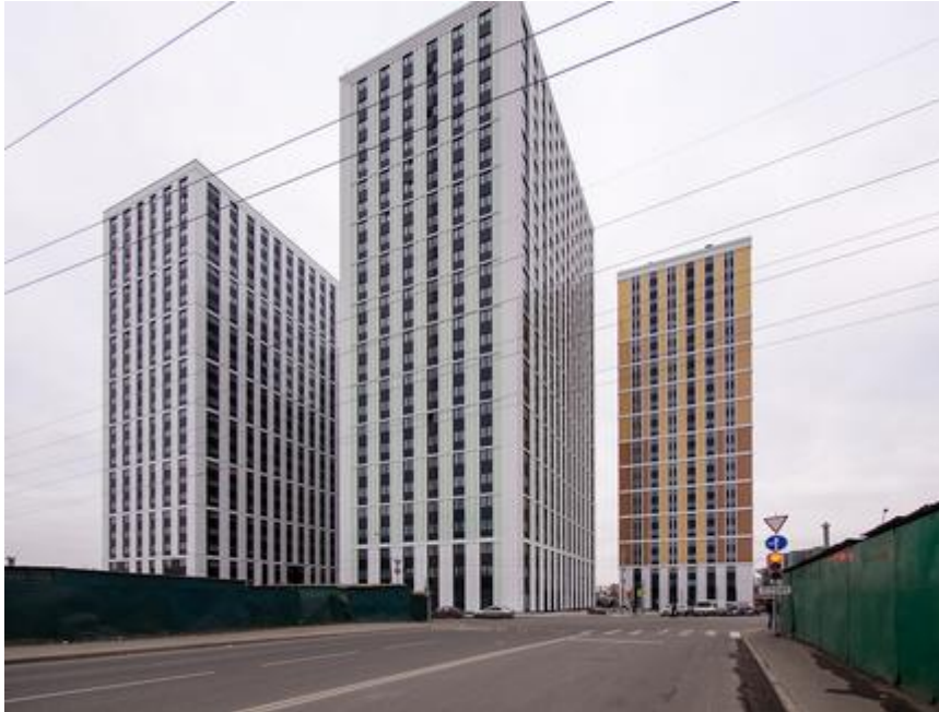
Фото 6.3. Ход строительства многофункционального комплекса 1
